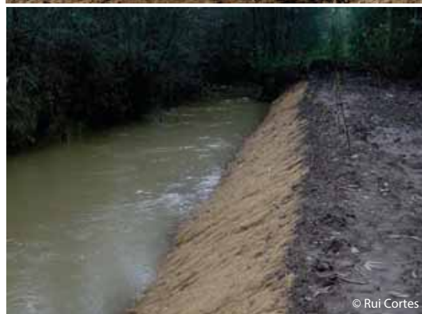
Trabalhos de recuperação de margens ribeirinhas. Corte de canal na ribeira e preparação do solo para instalação de ripícolas
